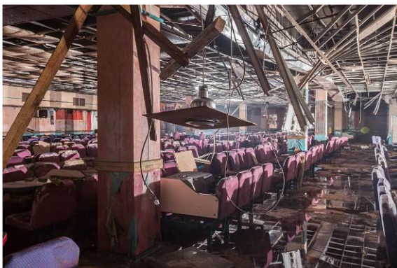
Sous les appartements de Red Road, une salle de bingo abandonnée pouvant accueillir 100 personnes a été fermée dans les années 90. Elle avait été ouverte une dernière fois avant la démolition de l'immeuble.
